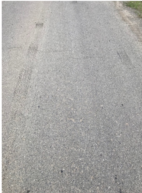
Рис. 1. Следы торможения автомобиля с ABS, отобразившиеся на асфальтовом покрытии
